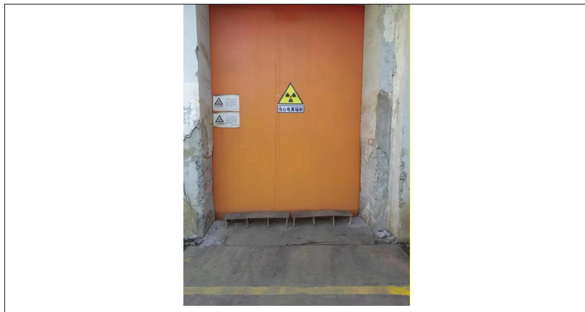
图 3-7 工件大门 1m 处警戒线
